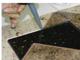
Nach dem Hinterfüllen der Fuge mit der passenden **OTTOCORD PE-B2 Rundschnur** wird die Fuge mit dem geeigneten OTTO Silicon verfüllt. Dann wird der Dichtstoff geglättet.
