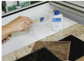
Danach wird das **OTTO Glättwerkzeug** wieder benetzt und die Fuge in der genannten Technik weiter geglättet. Nach dem Glätten müssen die auf den Fliesen oder Platten verbliebenen Rückstände des Glättmittels entfernt werden, um Fleckenbildung zu vermeiden. Das Ergebnis ist eine perfekte Fuge.
