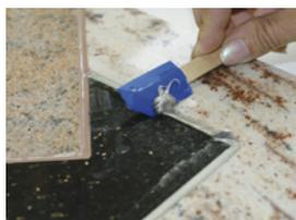
Mit der jeweils passenden Kante wird das mit Glättmittel benetzte **OTTO Glättwerkzeug** über die verfüllte Fuge gezogen.
